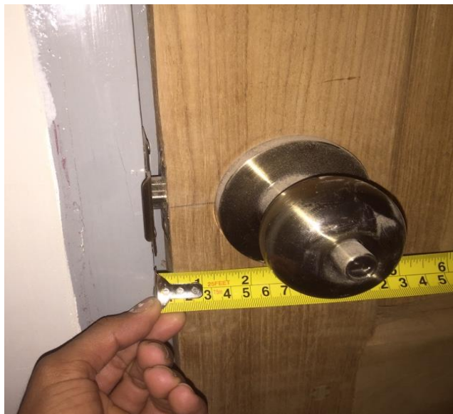
Fig:(02) Ground floor နှင့် First floor ရှိ Timber door များတွင် တံခါးရွက်နှင့် ကျည်းဘောင်ကြား အဟအကျယ် သည် 10mm to 12mm ဝန်းကျင် ရှိနေသောကြောင့် Lock အဝင်နည်းနေခြင်း နှင့် အချို့တံခါးများတွင် Lock ချမရခြင်းများအား ပြုပြင်ပေးရန်။
