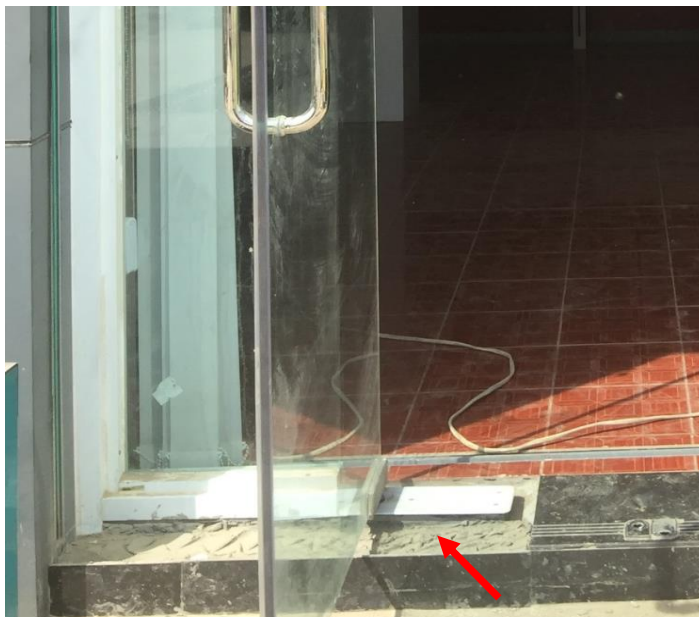
Fig:(19) Ground floor, Entrance door အောက်တွင် ကြွေပြားနှစ်ချပ်ကပ်ရန် ကျန်သေးသည်။
