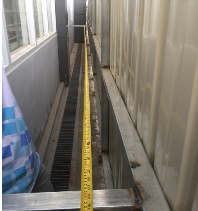
Fig:(15) 4 - Angle Fencing အား နံရံနှင့် အမာခံထောက်ထားသော Horizontal frame (21'-8" c/c) တပ်ဆင်ထားမှုသည် ခိုင်ခံ့မှု အားနည်းနေသောကြောင့် ညှိနှိုင်းပြုပြင်ပေးပါရန်။
