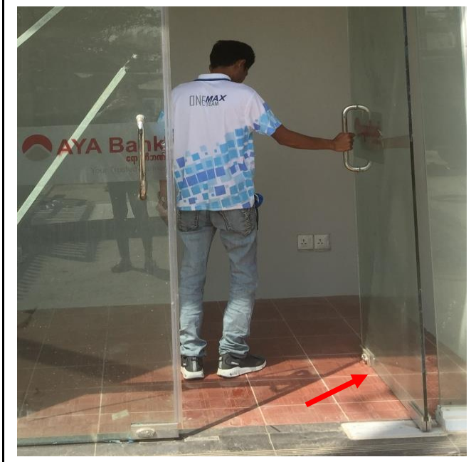
Fig:(06) ATM ခန်းသို့အပင် Tempered Door ၏ ညှာဖက်တံခါးရွက်အားဖွင့်ရာတွင် အောက်ခြေကြမ်းခင်း ကြွေပြားနှင့်တိုက်နေသောကြောင့် ပြုပြင်ပေးရန်။
