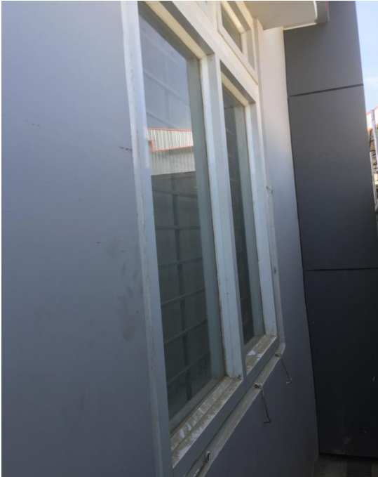
Fig:(08) Ground floor နှင့် First floor ရှိ Aluminium Sliding Window များအားလုံးကို တံခါးအဖွင့်အပိတ်လွယ်ကူမှု ရှိအောင် ပြုပြင်ပေးရန်။ ပြင်ပနှင့် ဆက်စပ်နေသော တံခါးများပြတင်းပေါက်များအား အတွင်းမှ Lock ချိတ်ပြီး အပြင်ပိုင်းမှ ရေထိုးစမ်းသပ်ပေးရန်။ (ရေပင်ရောက်မှု ရှိ/မရှိ ကြိုတင်သိနိုင်ရန်အတွက်)
