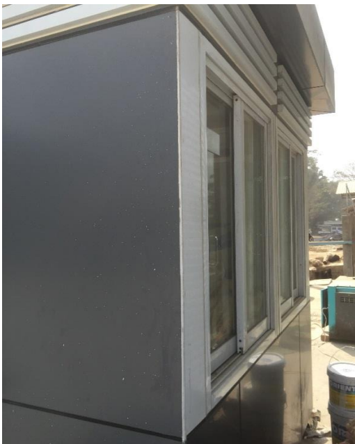
Fig:(58) Mobile security Hydraulic door နှင့် Aluminium sliding window များမှာ အဖွင့်အပိတ်ကြပ်နေပါသဖြင့် ပြုပြင်ပေးရန်။
