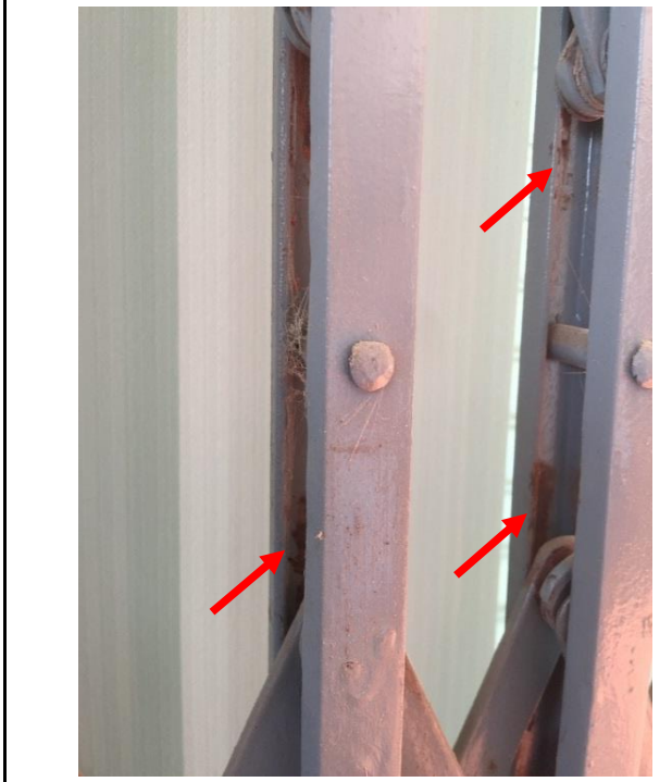
Fig:(31) GL-1/ A-B (Ground floor) ရှိ Bajar Door ၏ Welding သားများအား လက်ရာသေသပ်စွာ ပြုပြင်ပေးရန်။
