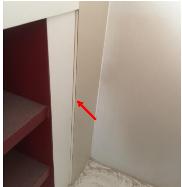
Fig:(25) Teller Counter (Ground floor) အတွင်းပိုင်းနေရာများအားလုံးတွင် Laminate Finish (Bedge color) နှင့် White color (Shelf) နှစ်ခုအဆက်များတွင် Level flush မဖြစ်ပဲ တစ်နေပါသဖြင့် နောင်လုပ်ဆောင်မည့် လုပ်ငန်းများတွင် မျက်နှာပြင် တညီတည်း ပြုလုပ်ပေးရန်။ (ယခုတွင် ပြန်ပြင်စရာမလိုပါ။)
