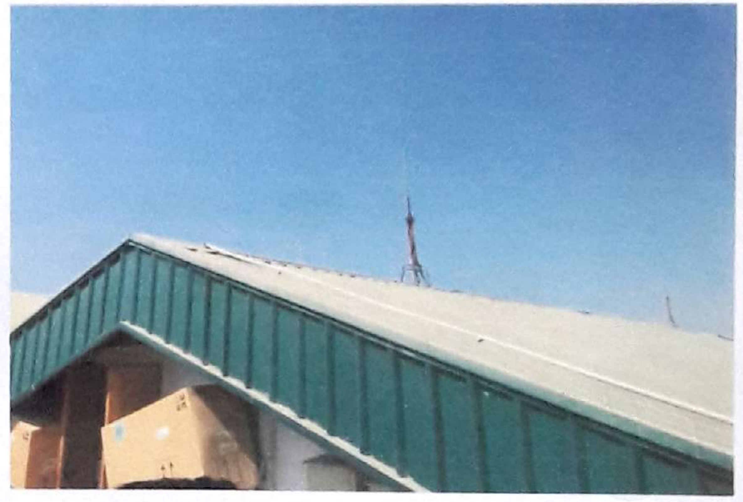
Fig:(60) Roofing တပ်ဆင်ထားခြင်း လုပ်ငန်းများအား Building ၏အတွင်းပိုင်းသို့ ရေတိုက်ရိုက်ရောက်ရှိနိုင်သော နေရာများကို ရေထိုးစမ်းသပ်ပေးပါရန်။
