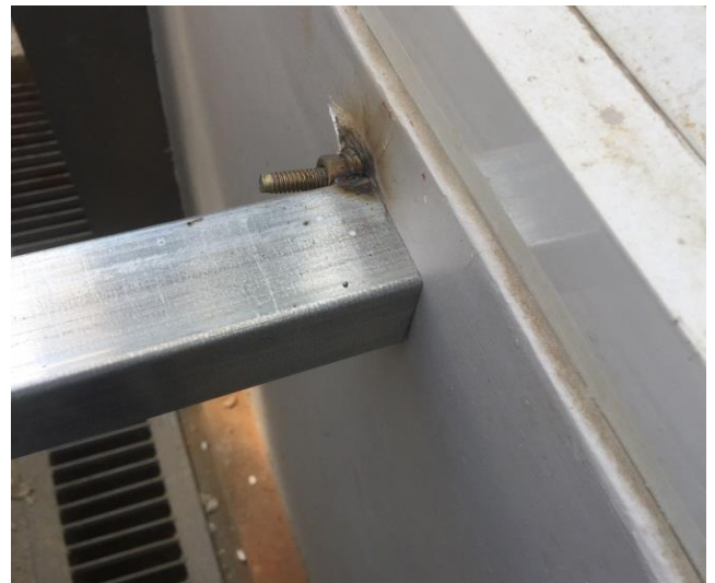
Fig:(16) 4 - Angle Fencing အား နံရံနှင့် အမာခံထောက်ထားသော Horizontal frame များ တွယ်ဆက်တပ်ဆင်ရာတွင် Wall plug တပ်ချောင်းဖြင့်သာ တွယ်ဆက်ထားပါသဖြင့် ခိုင်ခံ့မှုအားနည်းနေသောကြောင့် အနည်းဆုံး Wall Plug နှစ်ချောင်းဖြင့် Frame ဘေးနှစ်ဖက်မှ တွယ်ဆက်တပ်ဆင်ပေးရန်။
