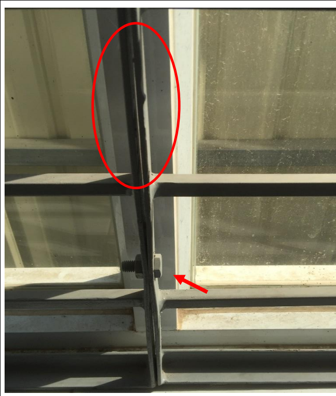
Fig:(39) Ground floor,W02 (GL-C/3-4) ရှိ Irongrill ၏ ဆေးသားမျက်နှာပြင်တွင် ဆေးသီးနေခြင်းနှင့် Vertical frame ခွက်နေခြင်းအား ပြုပြင်ပေးပါရန်။
