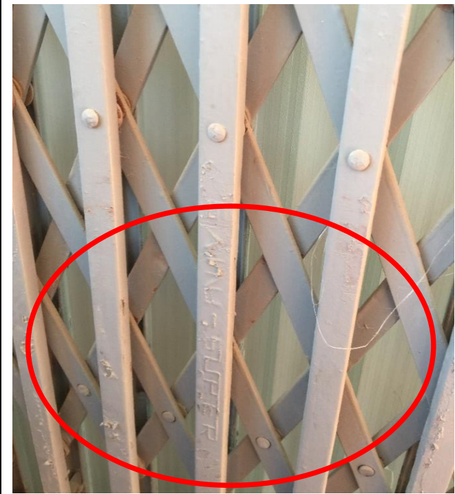
Fig:(34) All areas ရှိ Bajar door များ၏ မျက်နှာပြင်ရှိ ဆေးကွာနေသောနေရာများအား သေချာစွာ ကော်ပတ်စား၍ ဆေးပြန်လိုက်ပေးရန် နှင့် အဖွင့်အပိတ်ကြပ်နေသည်ကို ပြုပြင်ပေးရန်။
