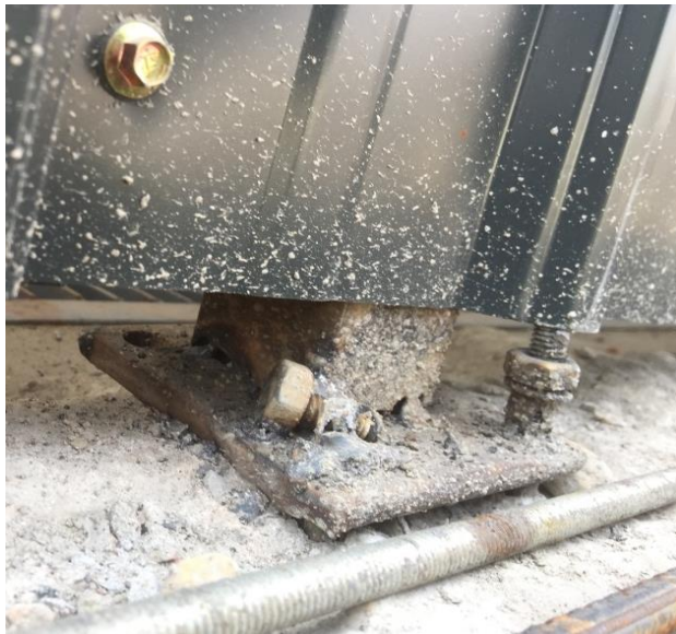
Fig:(14) 4 - Angle Fencing ၏ Vertical Post များအား ကြမ်းခင်းနှင့် အမာခံတွယ်ဆက်ရာတွင် Wall plug လေးခုဖြင့် စနစ်တကျ တွယ်ဆက်တပ်ဆင်ပေးရန်။
