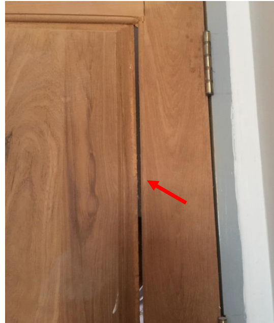
Fig:(01) Ground floor နှင့် First floor ရှိ တံခါးရွက်များအားလုံးတွင် ပုံပါအတိုင်း စရွေးများချောင်ကာ အလင်းဝင်ရောက်နေခြင်းကို ပြုပြင်ပေးရန်။
