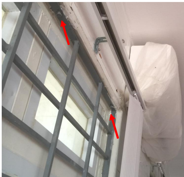
Fig:(41) Irongrill အားလုံး၏ Chowket frame ဘေးပတ်လည်တွင် တပ်ဆင်ထားသော Wall plug များအား နောင်လုပ်မည့်လုပ်ငန်းများတွင် တည့်မတ်စွာ တပ်ဆင်ပေးပါရန်။ (ယခုတွင် ပြန်ပြင်စရာမလိုပါ။)
