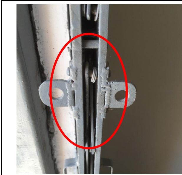
Fig:(31) GL-1/ A-B (Ground floor) ရှိ Bajar Door ၏ Welding သားများအား လက်ရာသေသပ်စွာ ပြုပြင်ပေးရန်။
