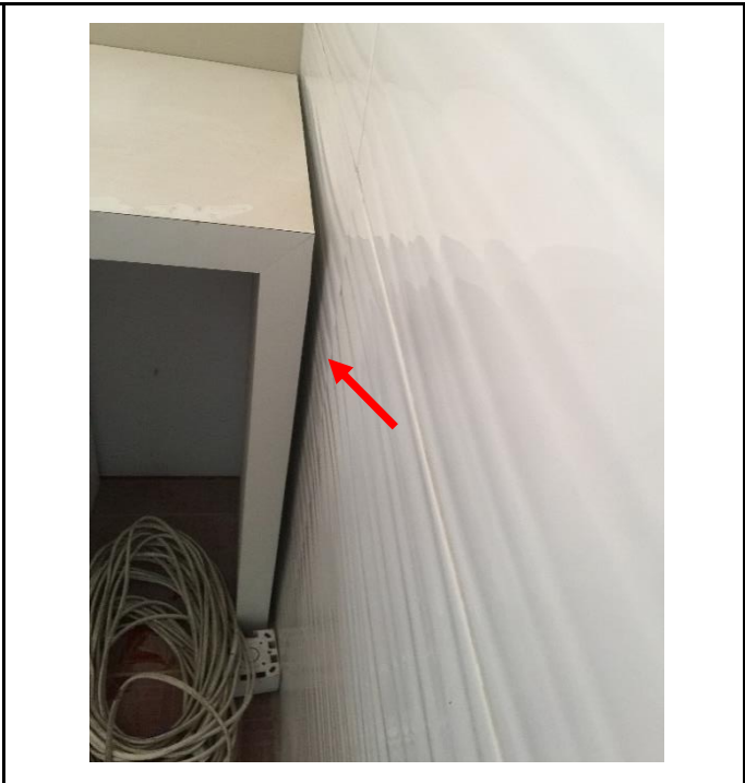
Fig:(21) Ground floor- Customer Service Counter နှင့် နံရံကြားဟနေသောနေရာအား Sealent ထိုးပေးရန်။
