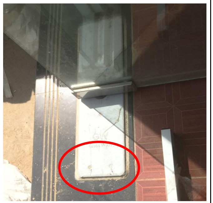
Fig:(07) ATM ခန်းသို့အပင် Tempered Door ၏ ဘယ်ဖက်တံခါးရွက်၏ ချုပ်ခွက်အား ကြွေပြားနှင့် Level အညီတင်ပေးရန်။
