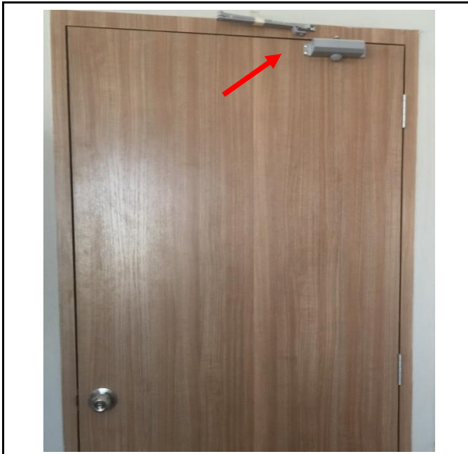
Fig:(04) Ground floor နှင့် First floor ရှိ Laminated door များအားလုံးတွင် Door closer-Link များပြန်ချိတ်ပြီး အဖွင့်အပိတ်ညှင်သာစွာ ပိတ်သွားခြင်း (Auto lock) နှင့် (Auto stop) ရပ်တန့်နေခြင်းရှိအောင် ပြုလုပ်ပေးရန်။
