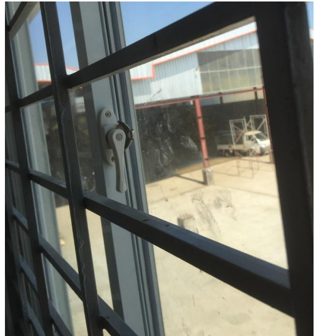
Fig:(08) Ground floor နှင့် First floor ရှိ Aluminium Sliding Window များအားလုံးကို တံခါးအဖွင့်အပိတ်လွယ်ကူမှု ရှိအောင် ပြုပြင်ပေးရန်။ ပြင်ပနှင့် ဆက်စပ်နေသော တံခါးများပြတင်းပေါက်များအား အတွင်းမှ Lock ချိတ်ပြီး အပြင်ပိုင်းမှ ရေထိုးစမ်းသပ်ပေးရန်။ (ရေပင်ရောက်မှု ရှိ/မရှိ ကြိုတင်သိနိုင်ရန်အတွက်)
