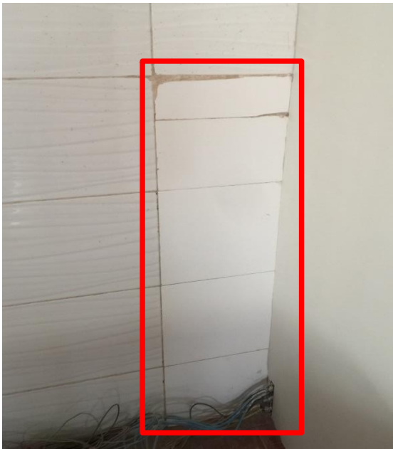
Fig:(17) Ground floor, Back office နောက် (Near GL-3) ရှိ Existing wall ties လေးချပ် Color မညီခြင်းနှင့် အပေါ် ဆုံးတစ်ချပ် ကွဲနေခြင်းအား Banking area လူမြင်ကွင်း ဖြစ်သောကြောင့် ပစ္စည်းအပိုရှိပါက လဲလှယ်ပေးစေလိုပါသည်။ (Shape & Color တူမှသာ)
