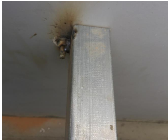
Fig:(16) 4 - Angle Fencing အား နံရံနှင့် အမာခံထောက်ထားသော Horizontal frame များ တွယ်ဆက်တပ်ဆင်ရာတွင် Wall plug တပ်ချောင်းဖြင့်သာ တွယ်ဆက်ထားပါသဖြင့် ခိုင်ခံ့မှုအားနည်းနေသောကြောင့် အနည်းဆုံး Wall Plug နှစ်ချောင်းဖြင့် Frame ဘေးနှစ်ဖက်မှ တွယ်ဆက်တပ်ဆင်ပေးရန်။
