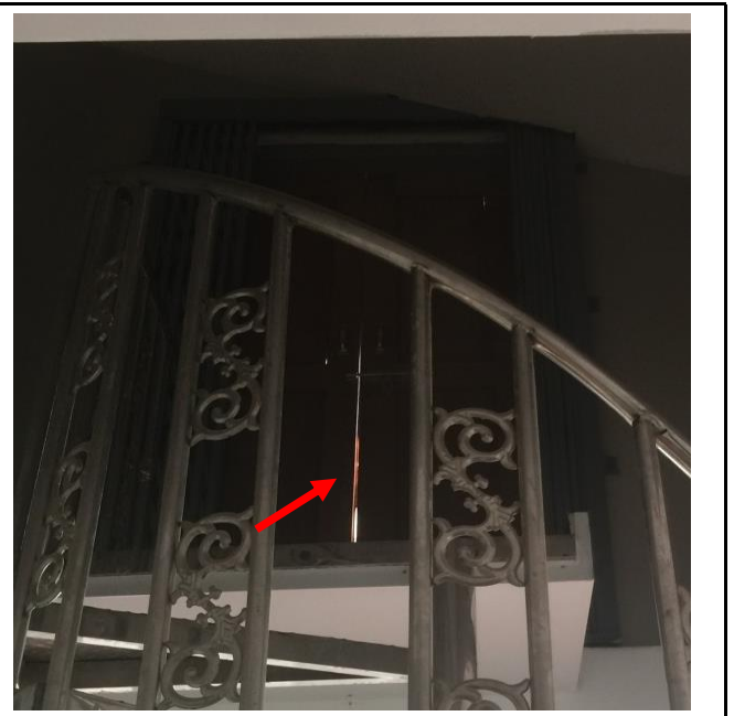
Fig:(05) Roof floor သို့အပင် တံခါးရွက်နှစ်ရွက်ဖွင့် တံခါး၏ ရင်စေ့နေရာတွင် ပုံပါအတိုင်း အလင်းဝင်ရောက် နေခြင်းများကို ပြုပြင်ပေးရန်။
