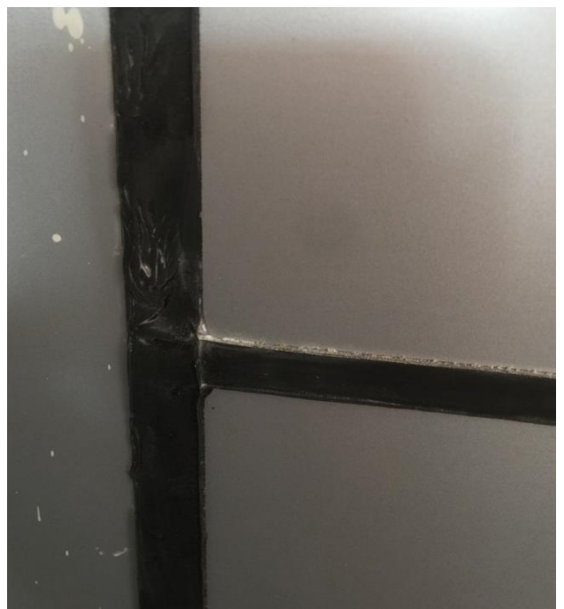
Fig:(09) Vault Room ရှေ့ Slide door တွင် Silicon အမဲရောင်ထိုးထားမှုအား Light Grey အရောင် ( As per Drawing) အတိုင်း ပြန်လည်အစားထိုးပေးရန်။
