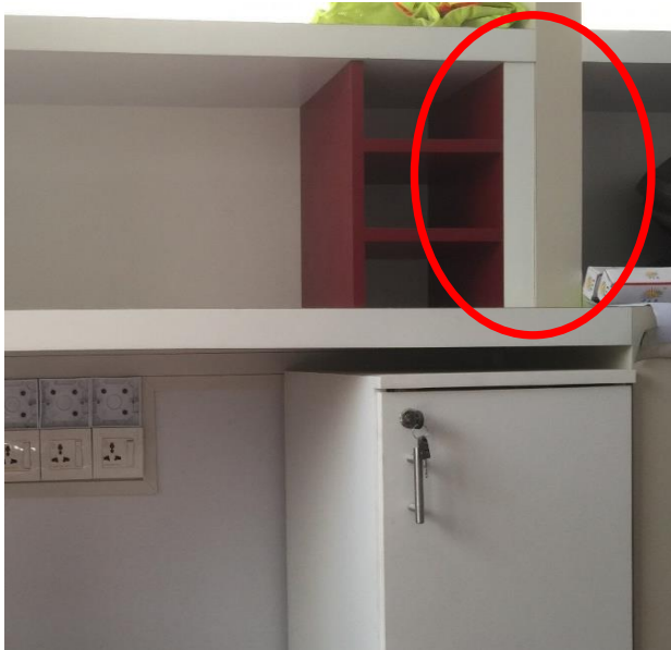
Fig:(25) Teller Counter (Ground floor) အတွင်းပိုင်းနေရာများအားလုံးတွင် Laminate Finish (Bedge color) နှင့် White color (Shelf) နှစ်ခုအဆက်များတွင် Level flush မဖြစ်ပဲ တစ်နေပါသဖြင့် နောင်လုပ်ဆောင်မည့် လုပ်ငန်းများတွင် မျက်နှာပြင် တညီတည်း ပြုလုပ်ပေးရန်။ (ယခုတွင် ပြန်ပြင်စရာမလိုပါ။)
