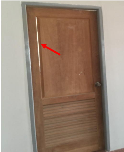
Fig:(01) Ground floor နှင့် First floor ရှိ တံခါးရွက်များအားလုံးတွင် ပုံပါအတိုင်း စရွေးများချောင်ကာ အလင်းဝင်ရောက်နေခြင်းကို ပြုပြင်ပေးရန်။
