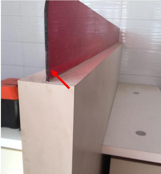
Fig:(23) Contract အရ Customer Service Counter-1&2 ရှိ Acrylic panel thk အား 6mm သုံးရန် သတ်မှတ်ချက်ကို On site တွင် Acrylic panel-3mm thk နှစ်ချပ်ပူးသုံးထားပါသဖြင့် ရေရှည်တွင် ပြန်ကွာနိုင်ပါ သောကြောင့် Contract သတ်မှတ်ချက်အတိုင်း လဲပေးရန်။
