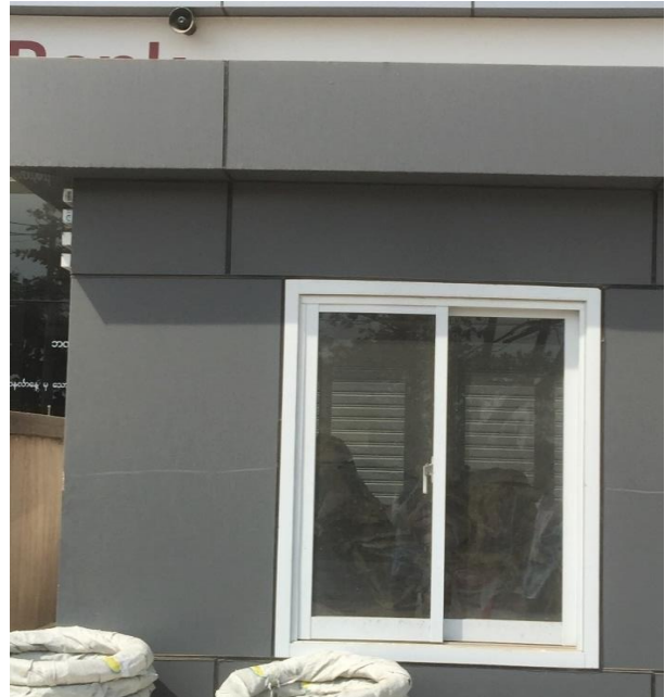
Fig:(58) Mobile security Hydraulic door နှင့် Aluminium sliding window များမှာ အဖွင့်အပိတ်ကြပ်နေပါသဖြင့် ပြုပြင်ပေးရန်။
