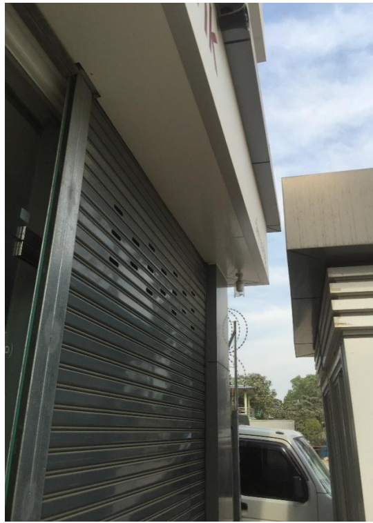
Fig:(37) Roller Shutter ကို Maintain လုပ်ငန်းများလွယ်ကူအဆင်ပြေစွာ ပြုလုပ်နိုင်ရန်အတွက် Composite အဖွဲ့မှ Manhole ပြုလုပ်ပေးပါရန်။
