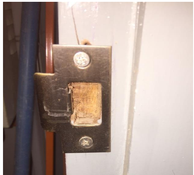
Fig:(01) Ground floor နှင့် First floor ရှိ တံခါးရွက်များအားလုံးတွင် ပုံပါအတိုင်း စရွေးများချောင်ကာ အလင်းဝင်ရောက်နေခြင်းကို ပြုပြင်ပေးရန်။
