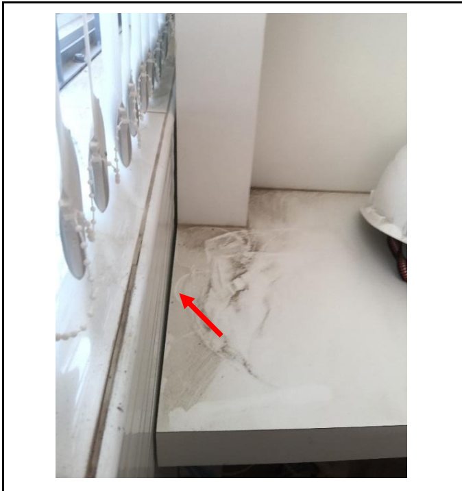
Fig:(20) Ground floor- Reception Counter နှင့် နံရံကြားဟနေသောနေရာအား Sealent ထိုးပေးရန်။
