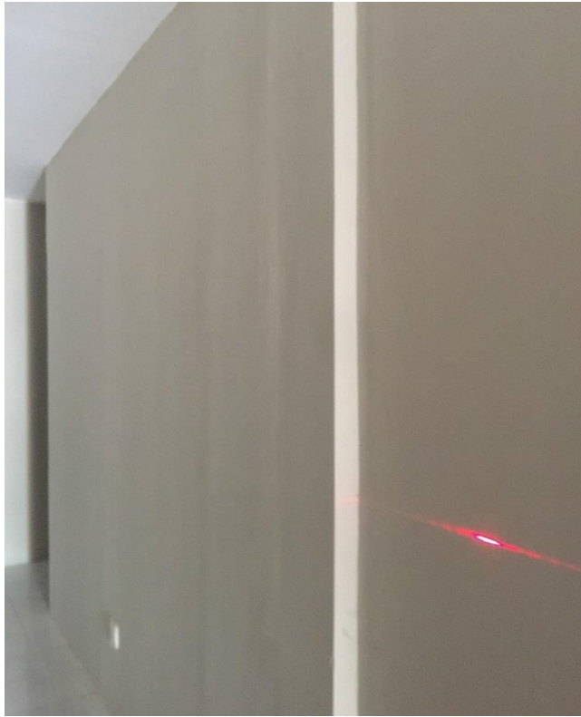
Fig:(51)Bed room-Ground floor ၏အတွင်းအပြင် Partition wall ဆေးများလှိုင်းထနေခြင်း နှင့် ဆေးကွက်နေခြင်းများအား ပြုပြင်ပေးရန်။
