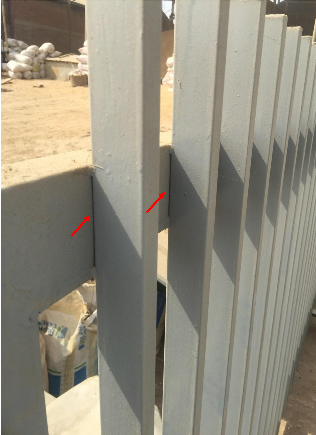
Fig:(54) တပ်ဆင်ထားသော Irongrill တပ်ချောင်းချင်းစီ၏ ဘေးနှစ်ဖက်အား နောက်ပိုင်းလုပ်ကိုင်မည့် လုပ်ငန်းများတွင် Welding အပြည့်ဆော်ပေးရန်။ (ယခုတွင် ပြန်ပြင်စရာမလိုပါ။)
