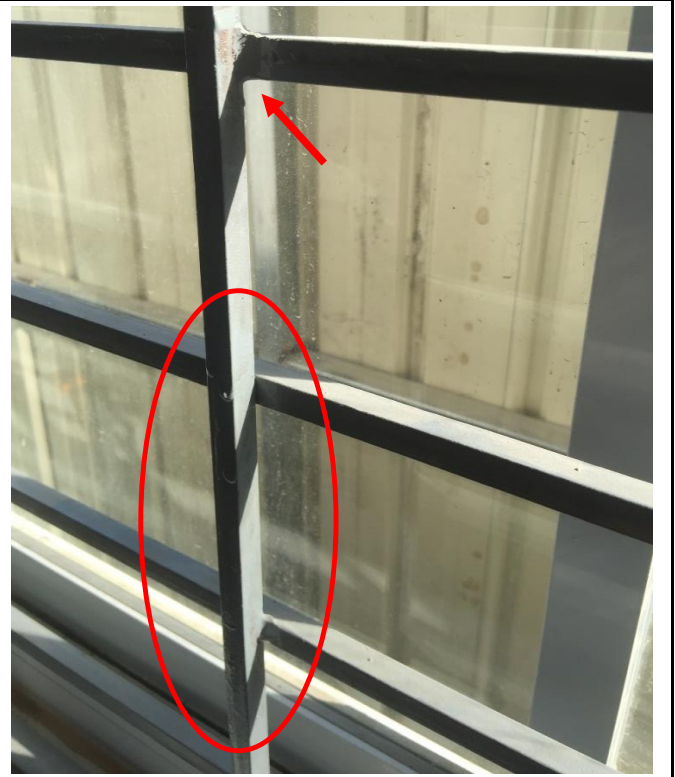
Fig:(40) Ground floor နှင့် First floor ရှိ Irongrill အားလုံး၏ ဆေးသားမျက်နှာပြင်တွင် ဆေးသီးနေခြင်းနှင့် ဆေးပဲ့နေခြင်းများအား ပြုပြင်ပေးပါရန်။
