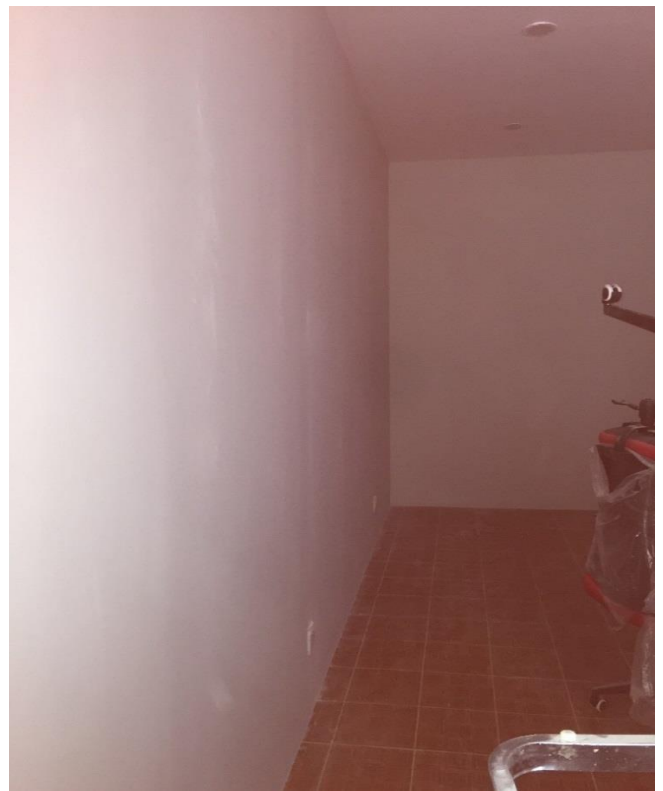
Fig:(52) First floor ရှိ Partition wall ဆေးများလှိုင်းထနေခြင်းအား ပြုပြင်ပေးရန်။ (Manager room မှ လွဲ၍)
